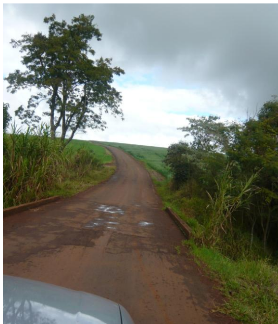
FIGURA 50 – ESTRADA DE ACESSO AO DISTRITO DE NOVA ALTAMIRA
