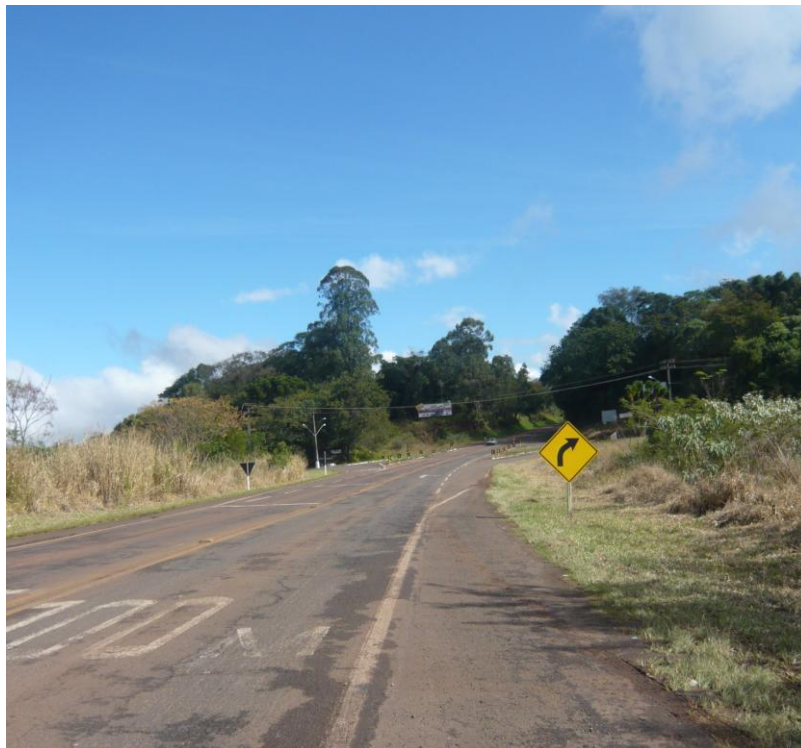
FIGURA 54 – SINALIZAÇÃO NO TREVO DE ACESSO À ÁREA URBANA DE FAXINAL
