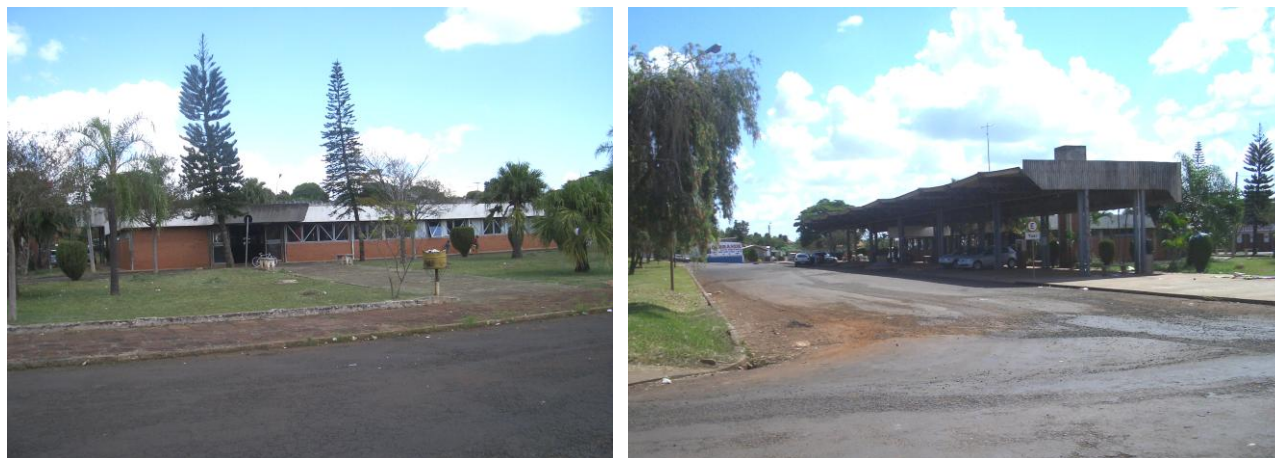
FIGURA 57– TERMINAL RODOVIÁRIO: VISTA DO ACESSO DE USUÁRIOS E ÔNIBUS, RESPECTIVAMENTE – FAXINAL, 2009
