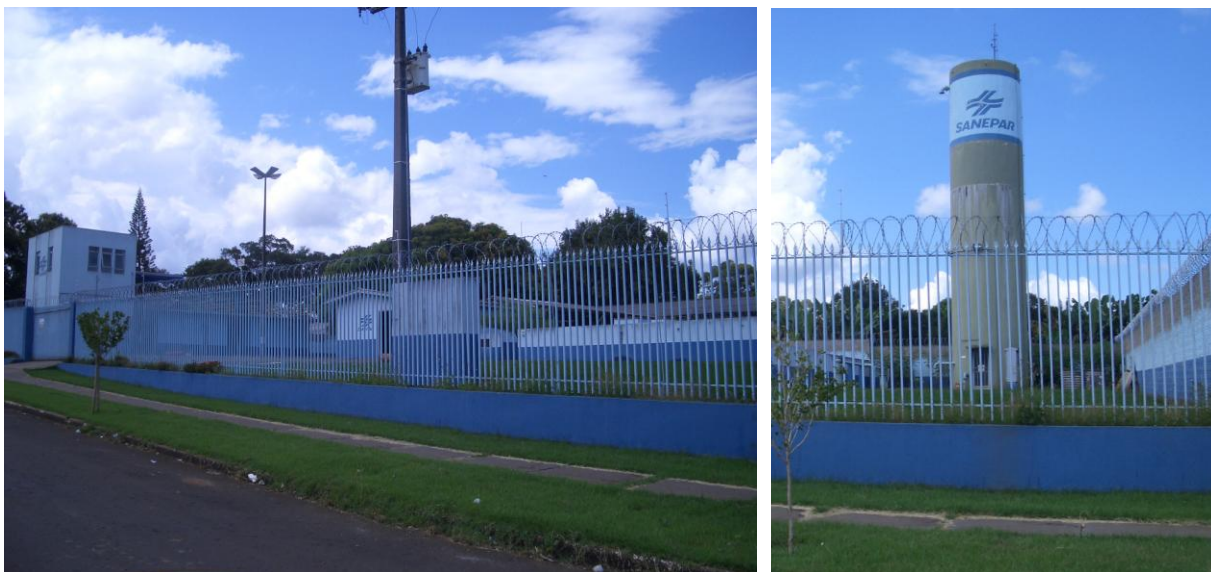
FIGURA 59 – ESTAÇÃO DE TRATAMENTO DE ÁGUA E RESERVATÓRIO DA SANEPAR
